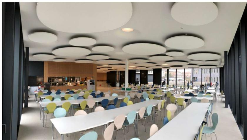
Baffles acoustiques sur mesure,
